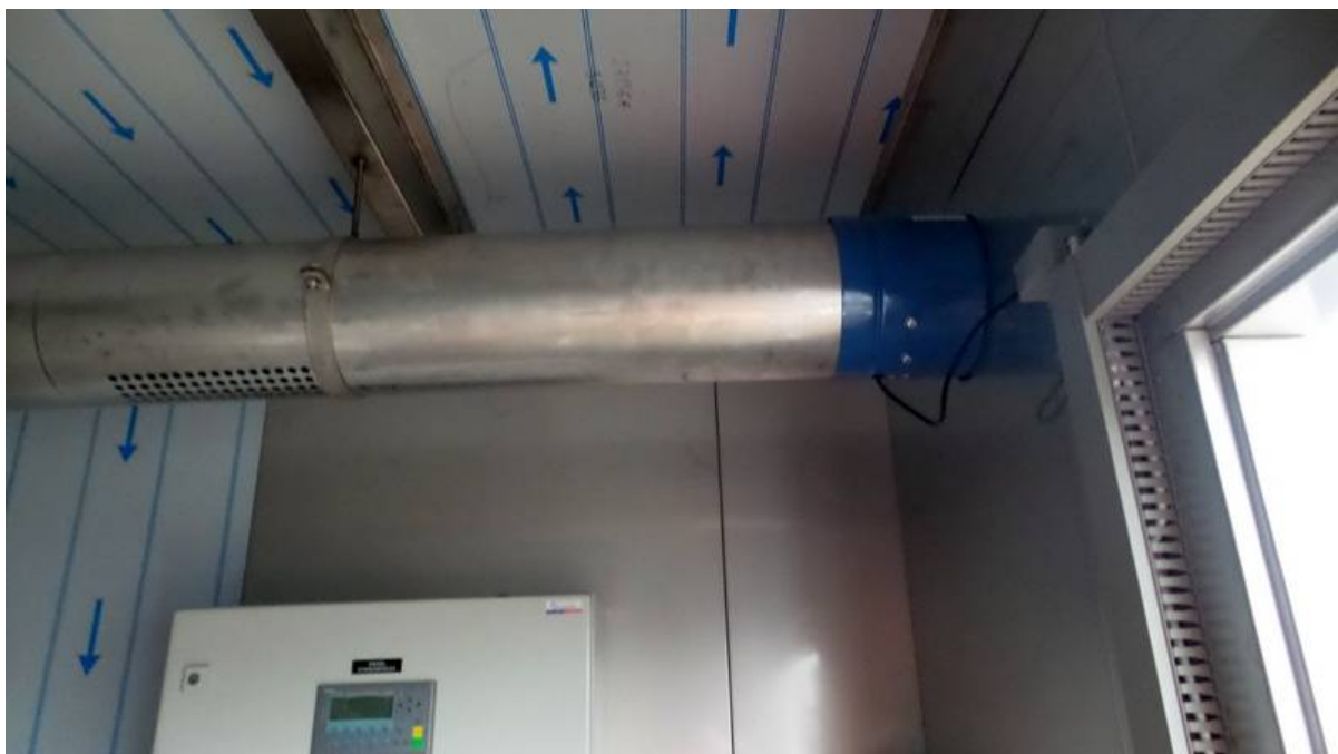
Obiekt nr 5 – stacja zlewna ścieków dowożonych.
